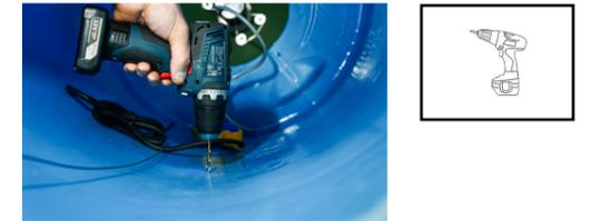
**Steg 8** Montera FeedCon på ett lämpligt ställe i tunnan så att kabeln från motorn når FeedCon enheten.
